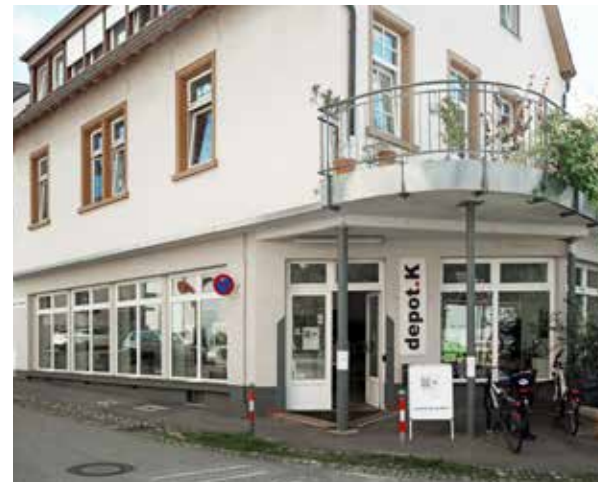
depot.K e.V. Kunstprojekt Freiburg, Hauptstraße 82, 79104 Freiburg
